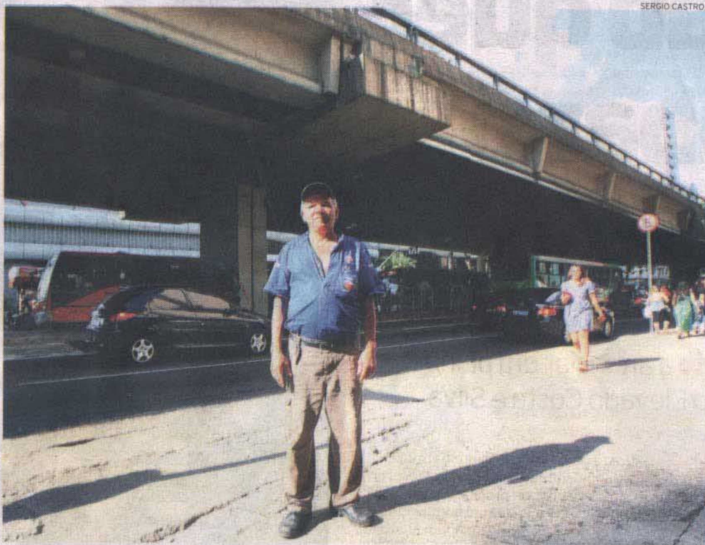
O frentista Manoel dos Santos trabalha no local há 40 anos e acompanhou a construção do Elevado
