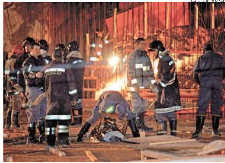
Acidente na obra da Fábrica de Cultura do governo estadual, na zona sul
